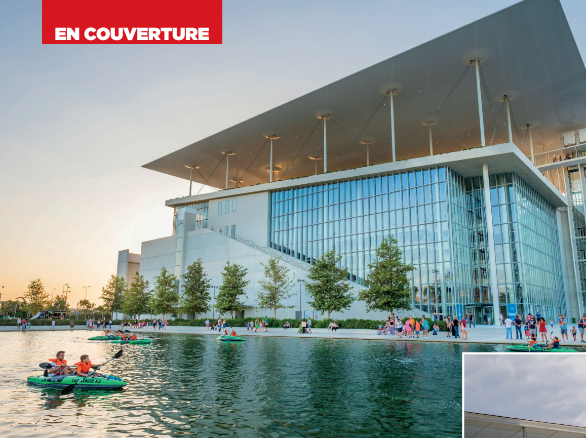
Kayak culturel. Bordant l'esplanade et ses airs d'agora du XXI e siècle, le canal où les Athéniens exercent leur corps, devant le Centre culturel. Sous le toit photovoltaïque, la terrasse, prolongée par un porte-à-faux, offre une vue à 360 degrés sur la ville et la mer.
